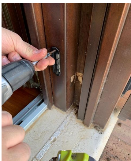
2 Fissare le clip laterali in dotazione sul dove si vuole installare la zanzariera
