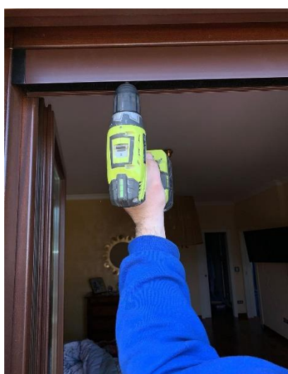
1 Fissare la guida superiore
